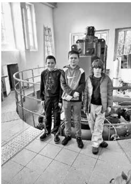
Am Nationalen Zukunftstag nutzten mehrere Schüler die Gelegenheit, zusammen mit den Erwachsenen die Anlage und Technik im Kleinkraftwerk Kernmatt von ganz nahe zu bestaunen.
